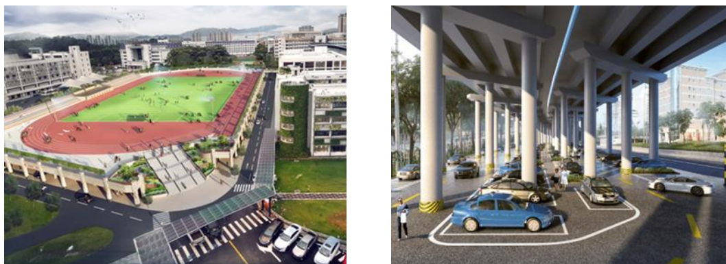
图 45 兼容性公共停车场（左图利用学校操场地下空间、右图利用高架桥桥下空间）
